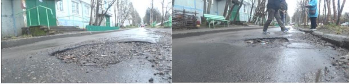
На одной территории отремонтирован участок площадью 141,0 м<sup>2</sup> вместо запланированных двух участков общей площадью 24,0 м<sup>2</sup>. Согласно представленной исполнительной документации подрядчиком производились работы на участке, не требующем ремонта, выполнение работ на втором планируемом участке не производилось. Также установлены признаки несоблюдения требований к продольным и поперечным уклонам, в результате чего на
